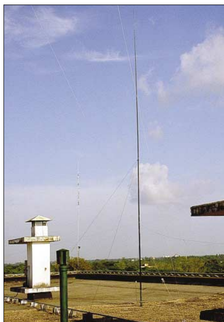
Vertikalantenne für 30 m; im Hintergrund die R7 auf dem Hoteldach in Yangon
